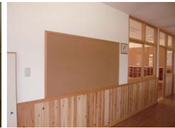
木枠掲示 板（廊下）
