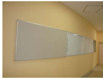
R型壁面：アルミ枠 掲示 板
